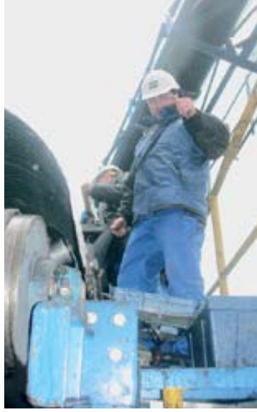
Martin Engineering teknisyeni Karadeniz’de bir kömür ocağında bir sıyrırcı montajı sırasında
